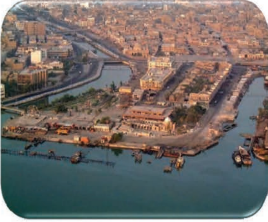
الصورة (١) ميناء أم قصر
