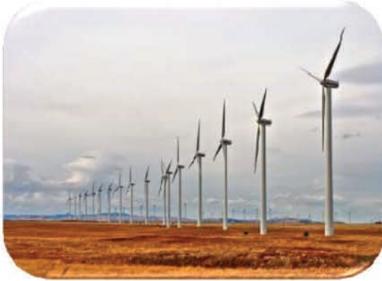
الصورة (١٨) توليد الكهرباء
