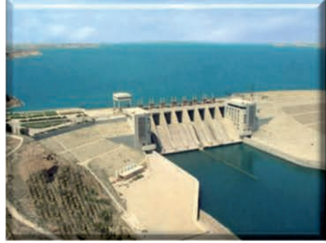
الصورة (24) بحيرة الطبقة الصناعية خلف سد الفرات
