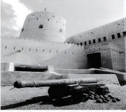
الشكل (٨) القلعة البرجية في نزوى بناها سلطان بن سيف العربي الذي طرد البرتغاليين من عُمان
