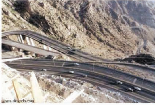
الصورة (٧) شق الطرق في الجبال لتهيئتها
