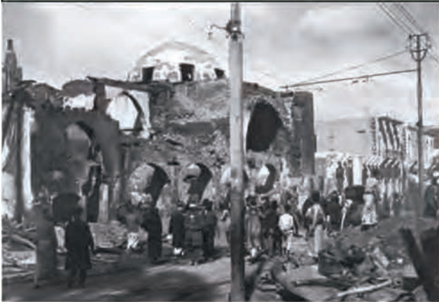
الشكل (٥) نتائج قصف فرنسا لحبي سيدي عامود الذي عُرف فيما بعد بحبي الحريقة بدمشق عام ١٩٢٥م.
